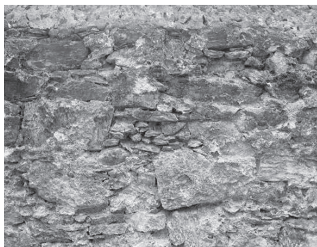
Muro posteriore (particolare)
