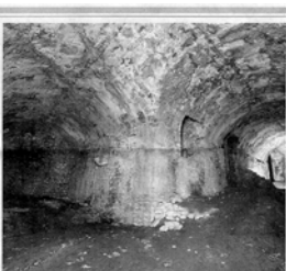
INTERNO del bastione. La foto evidenzia il pilastro centrale - su quale sono state gettate le volte delle gallerie in casamatta destinate ad alloggiare le batterie di artiglieria. (www.fotografantoni.ch)
